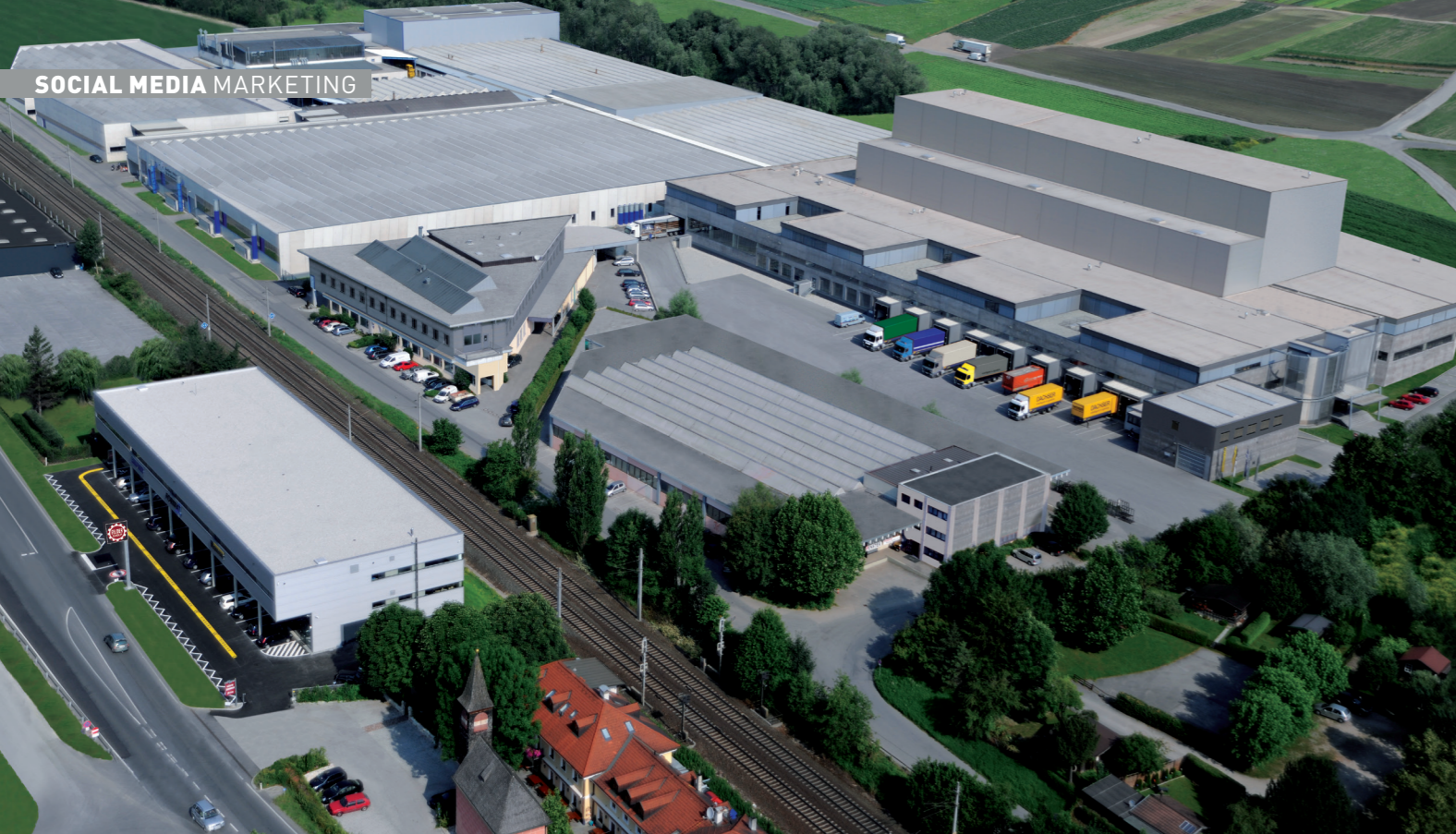
Am Hauptentwicklungsstandort in Hall in Tirol hat der Maschinenbauer Felder mit dem Bau eines 5.100 Quadratmeter großen Logistikzentrums begonnen.
