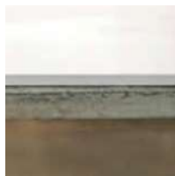
Hier ist keine Fuge zwischen Fläche und Kante zu erkennen
